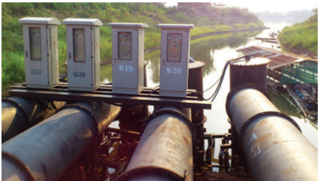
Bốn máy bơm trên đập tạm bơm nước từ cửa sông Huai Luang/Mê Kông lên đoạn hạ lưu đập/cửa van
