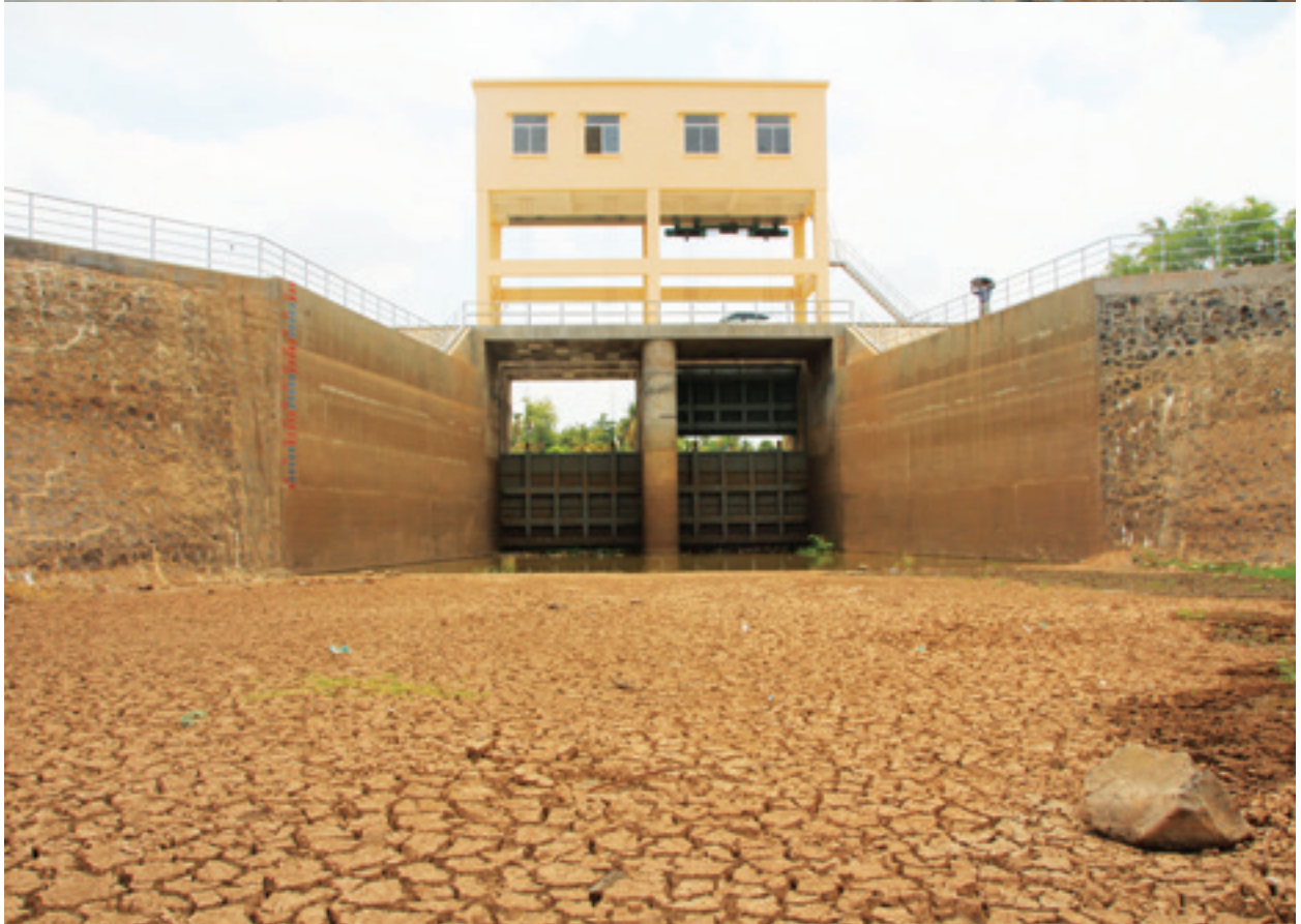
Cửa nước Dom Nak Prean chuyển nước từ sông Samdei (dòng nhánh của Mê Kông) vào hồ Krapik (tỉnh Kampong Cham, Campuchia)
