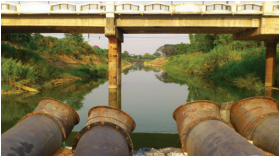
Đập tạm và đầu xả của bốn ống bơm nước bơm lên đoạn sông Huai Luang phía hạ lưu đập/cửa van
