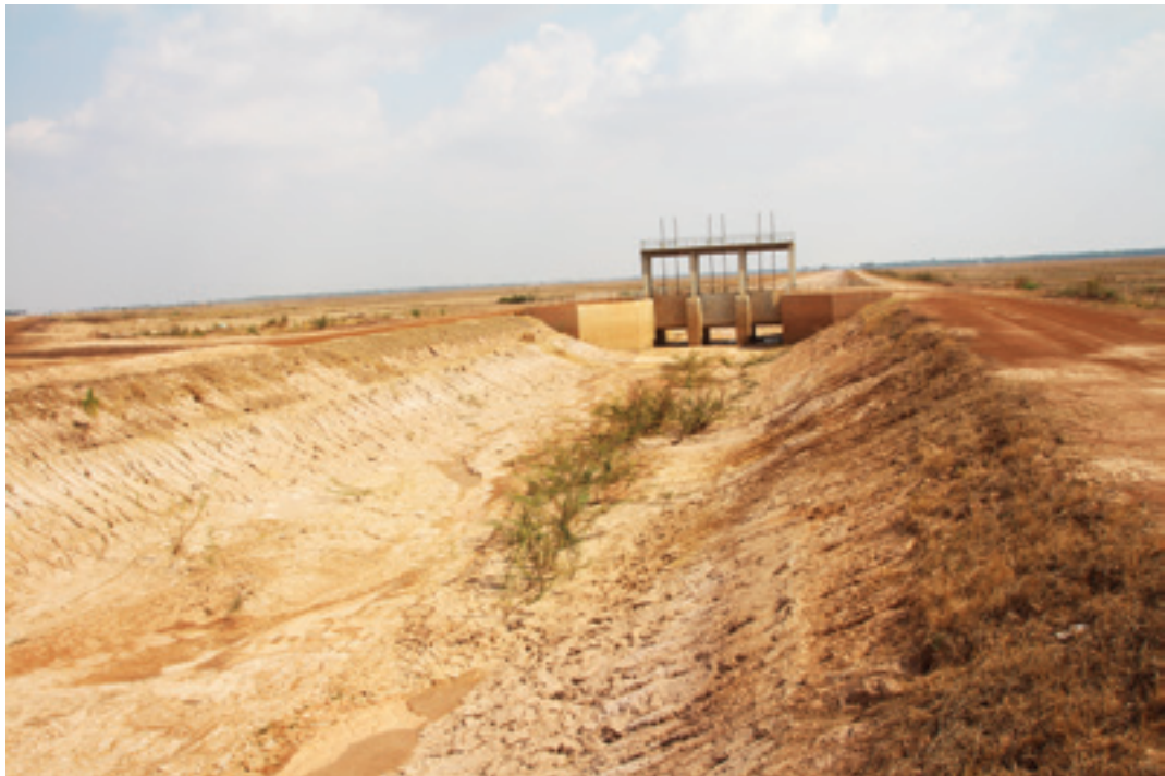
Kênh nhánh đi phía Neak Leuong có cửa cống để trữ nước khi cần
