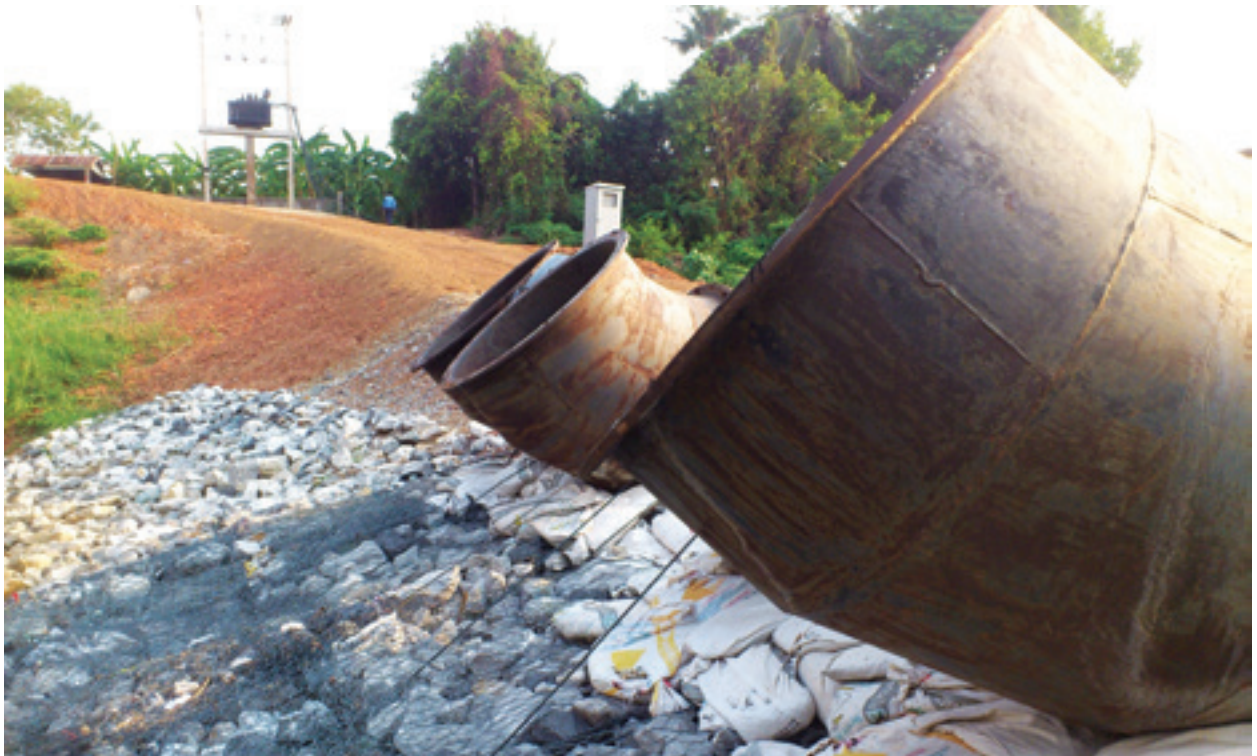
Dàn máy bơm bơm nước sông Mê Kông tại Huai Luang, Thái Lan
