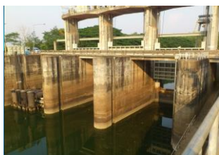
Cửa cống/đập có bơm phía bên trái để bơm nước lên trên đập
