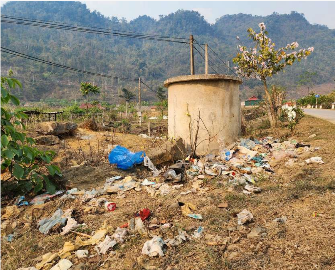
Hình ảnh bể thu gom rác thải tại Xuân Nha
